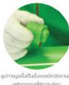
รูปถ่ายขณะใช้หัวเชื่อมอานม้ากับท่อจากการให้ความร้อน
